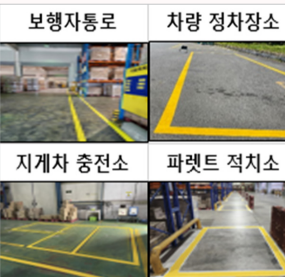
* 안전선/안전마크 도색 작업
