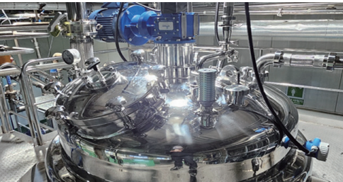
직결식 배기라인 설치
