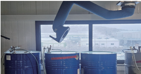
계량실 압후드 설치
